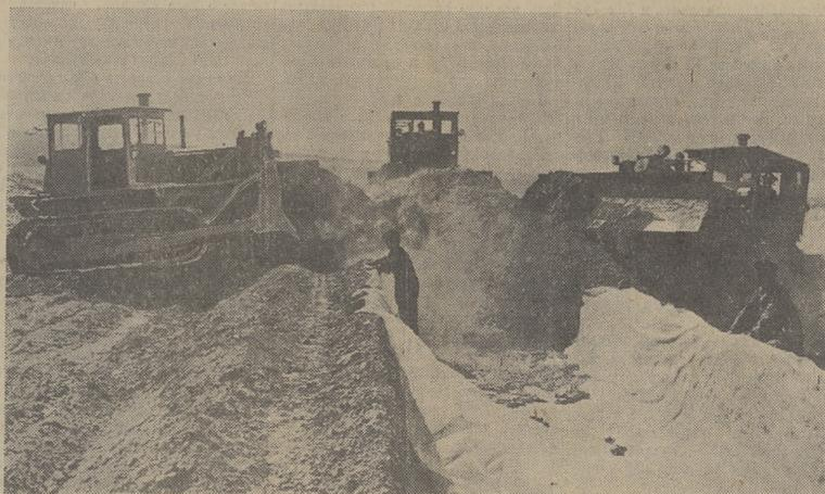
КАЗАХСКАЯ ССР. На строительстве оросительных каналов в целинном совхозе № 17 Урюково-Казахстанской области применяются полиэтиленовая и полихлорвиниловая пленки. Ими закрывают дно и стенки канала, а затем засыпают небольшим слоем земли. Защищенное пленкой русло не пропускает воду в почву.
