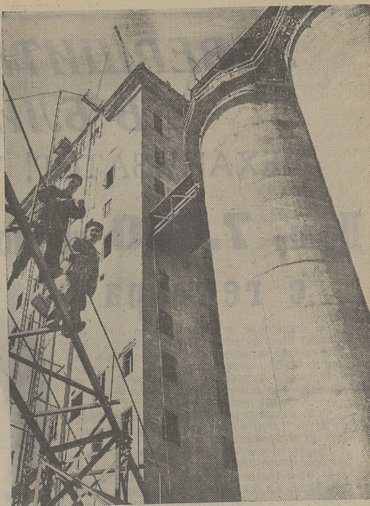
КАЗАХСКАЯ ССР. На полях республики еще идет весенний сев, работники элеваторов и хлебоприемных пунктов уже готовятся к приемке зерна нового урожая. В Актобинской области в этом году сооружаются четыре крупных механизированных элеватора. Один из них — Мартукский будет вмещать 18 тысяч тонн зерна. На снимке: на строительстве первой очереди Мартукского элеватора. (Фотохроника ТАСС).
