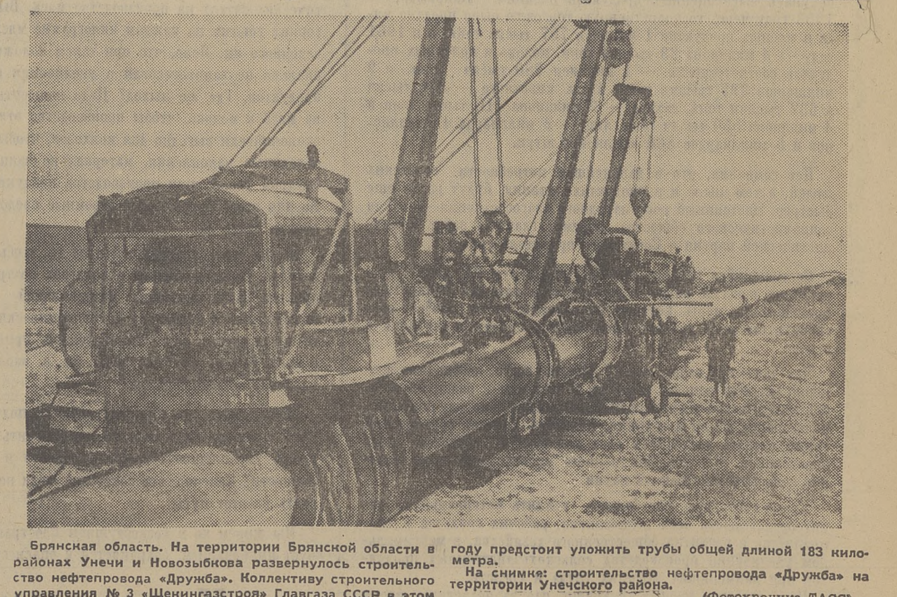
Брянская область. На территории Брянской области в районах Унечи и Новозыбкова развернулось строительство нефтепровода «Дружба». Коллектив строительного управления № 3 «Центрострой» Главгэз СССР в этом году предстоит уложить трубы общей длиной 183 километра.
