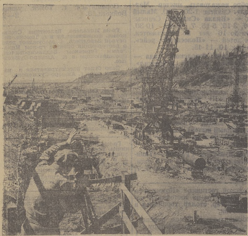
КРАСНОЯРСКИЙ КРАЙ. Широко раскинулся огромный котлован строящегося Красноярской ГЭС. Работы здесь не прекращаются ни днем, ни ночью. Коллектив строителей готовится к проведению больших бетонных работ. Идет монтаж кабель-кранов и кранового хозяйства. Продолжается бетонирование основания плотин. В Дивногорске — поселке строителей — возводятся многоквартирные жилые дома.
