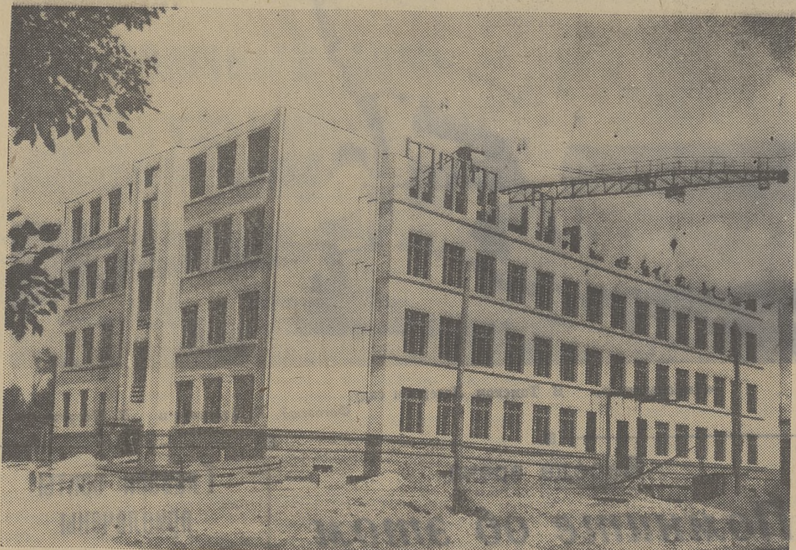
На углу улиц Герцена и Крылова г. Томска строится новое многоэтажное здание школы на 920 мест. Кладку стен и перекрытий ведет бригада
