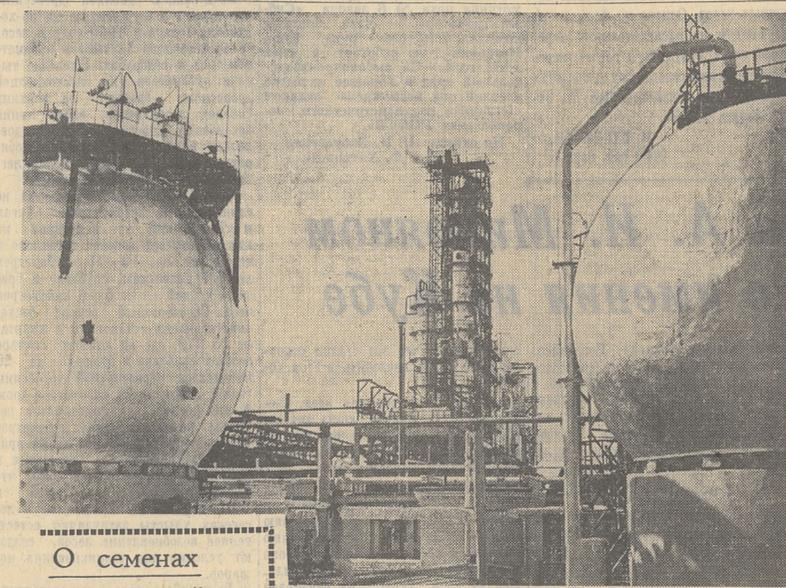
ВОЛГОГРАДСКАЯ ОБЛАСТЬ. Еще одна атмосферно-вакуумная установка (АВУ) вступила в эксплуатацию на Волгоградском нефтеперерабатывающем заводе. Вы видите ее на снимке. В сутки она вырабатывает тысячи тонн светлых нефтепродуктов. Все процессы производства здесь полностью автоматизированы. (Фотохроника ТАСС).
