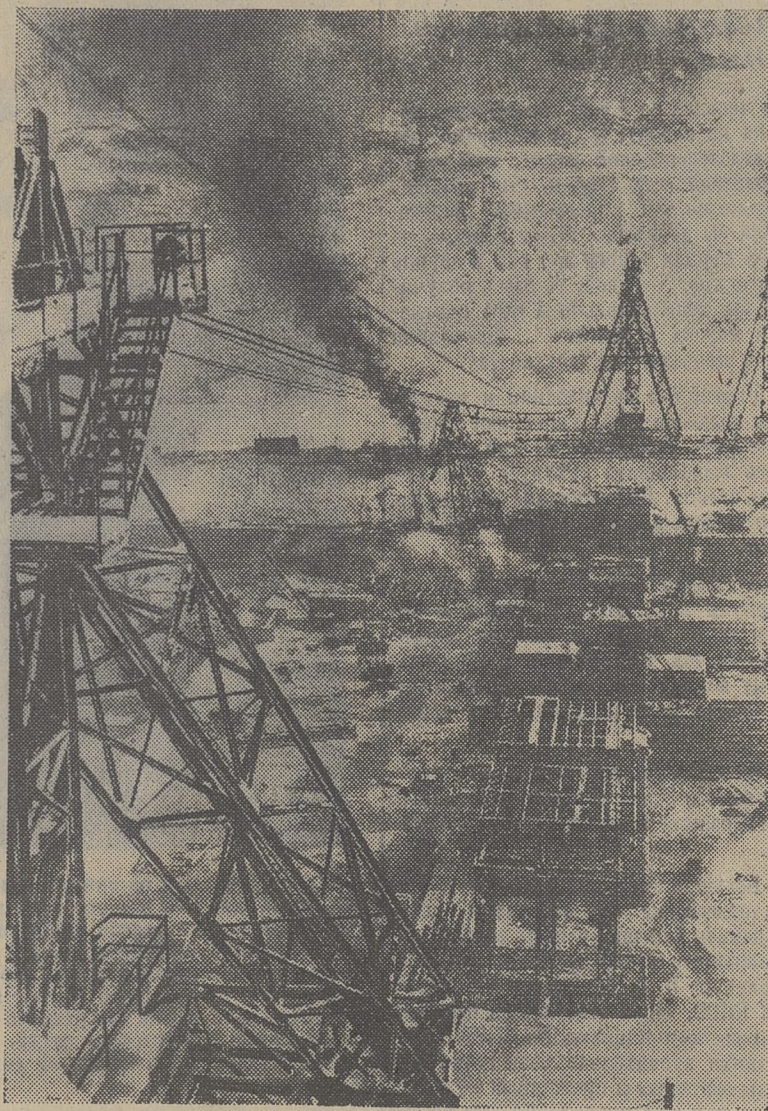
КРАСНОЯРСКИЙ КРАЙ. Горная порода у строительной крупнейшей в мире Красноярской ГЭС. Ближайшие день перекрытия мостовой сибирской реки Енисея. День и ночь кипит работа в котловане. Растут перемычки. До правого берега осталось не более 65 метров.
