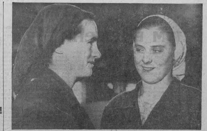
Передовые работницы волочьинского цеха завода «Томкабель» Е. Ф. Аноприева и В. Н. Подъячева. На снимке (слева направо): ударник коммунистического труда Елена Федоровна Аноприева и Вера Нидосрочно выполнили годовое задание. С октября колхоза Подъячева.
