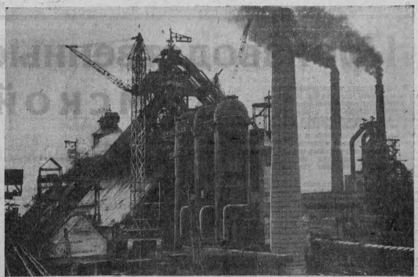
ОРЕНБУРГСКАЯ ОБЛАСТЬ. На Орско-Халиловском металлургическом комбинате завершается сооружение новой доменной печи. Она оснащена современными приборами автоматического управления. С пуском этой домы производство металла на комбинате удвоится. На снимке: вид новой домы. (Фотохроника ТАСС).
