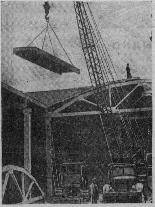
Рядом с действующими цехами вырисовываются контуры еще одного производственного корпуса Томского манометрового завода. Мощный кран, управляемый опытным специалистом Г. Н. Кашаковым, подает «нагора» многометровые железобетонные фермы и плиты для покрытия. Наверху рассыпаются снопы искр. Это сварщик А. М. Грищенко закрепляет сборные конструкции.
