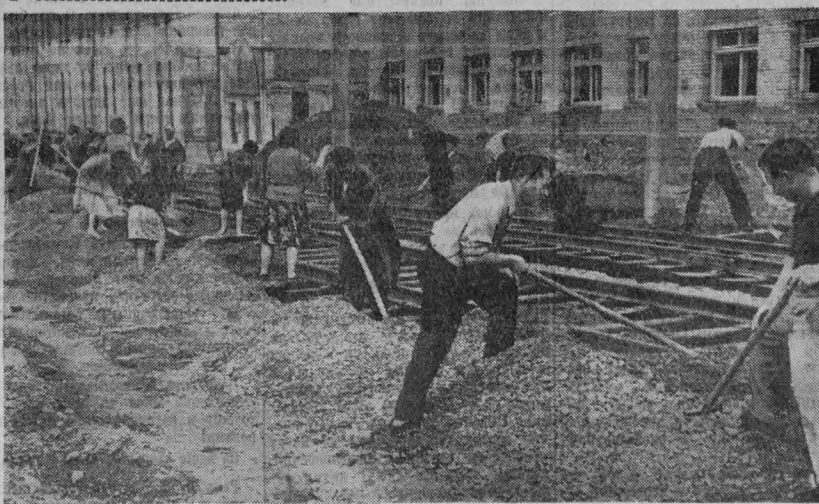
Активно участвуют в строительстве четвертой очереди трамвая работники манометрового завода. На снимке: приборостроители на суботнике по устройству трамвайного пути.
