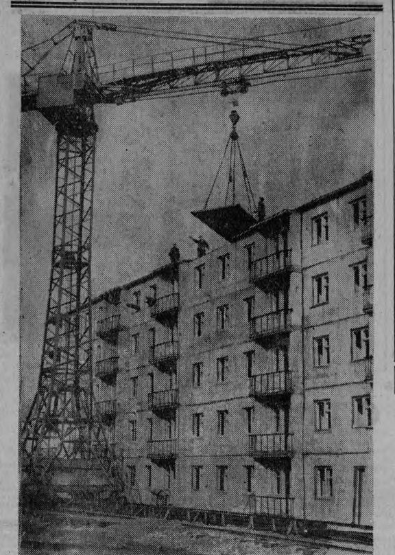
Из панелей завода сейчас смонтирован первый крупнопанельный дом. Монтаж его вел бригада из СУ-11 «Жилстрой» Александра Будного. Члены этой бригады — пионеры крупнопанельного домостроения в нашем городе, смонтировавшие еще один 80-квартирный крупнопанельный дом.
