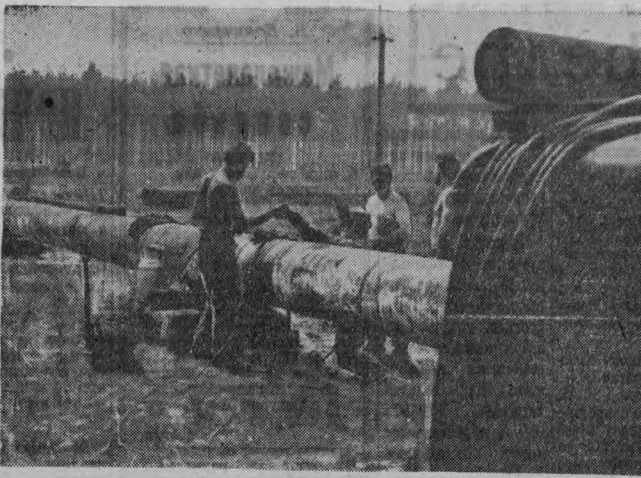
На снимке: монтажные работы на участке трассы близ Шведта-на-Одере (ГДР). (Фото АДН—ТАСС).
