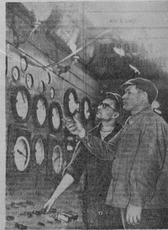
Котел современной электростанции — это сложное техническое сооружение высотой с трехэтажный дом. Все управление котлом — подача угля, приток воздуха, регулировка пламени — автоматизированы. Любое отклонение от заданных режимов работы котла немедленно обнаружат приборы и сообщат об этом на щит управления. За рабочим-машинистом остался лишь функции контроля. Труд рабочего превратился в инженерно-технический.
