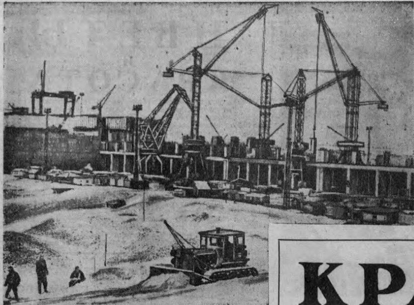
Дать в декабре промышленный ток — под таким девизом работают строители Киевской-Комсомольской ГЭС. Лучшие бригады переброшены на пусковые объекты. С начала года в основные сооружения уложено 80 тысяч кубометров бетона, перемещено около 4 миллионов кубометров грунта. Быстрыми темпами ведется монтаж закладных частей для первых четырех гидротурбин. Как известно, здесь устанавливаются горизонтальные турбины капсульного типа, изготовленные Харьковским турбинным заводом имени С. М. Кирова.
