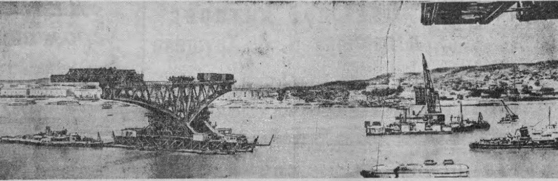
Строители крупнейшего в Европе автодорожного моста через Волгу одержали новую победу — всего за несколько часов с полнотой перевыполнили и установили на опоры третьи 120-метровые конструкции пролетного строения.
