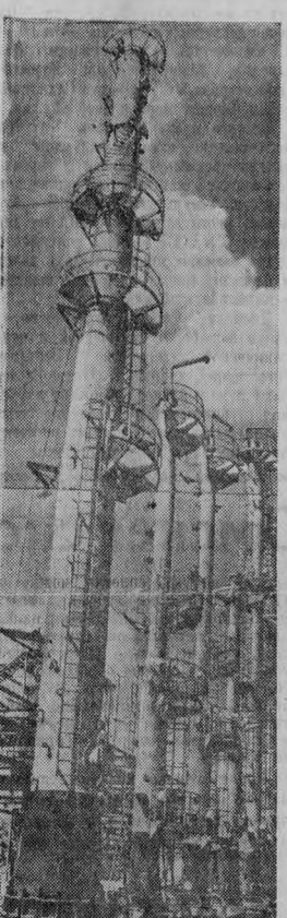
Монтаж технологического оборудования на предприятии «Лейна-1».
