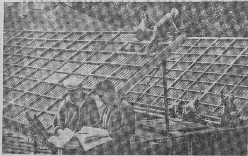
Солнечные водонагреватели площадью 200 квадратных метров смонтированы в городе Астрахани. 30 кубометров воды, нагретой до 50—60 градусов, используются на коммунальные нужды. На снимке: солнечные водонагреватели. На переднем плане — монтажники Федор Максимов (слева) и бригадир Вениамин Ванзин. Коллектив коммунистического труда, возглавляемый В. Ванзиным, смонтировал водонагреватели за месяц.
