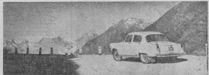
На высоте 3.500 метров над уровнем моря строятся последние километры автомобильной магистрали через Тянь-Шань.
