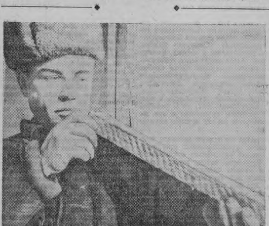
Николай Михайлович Ярыгин — бригадир строительного управления № 13 треста «Томскстрой». Бригада, которой он руководит, удостоена звания коллектива коммунистического труда. Разведчики будущего довели норму выработки до 170 процентов и трудятся сейчас в счет последнего года семилетки.
