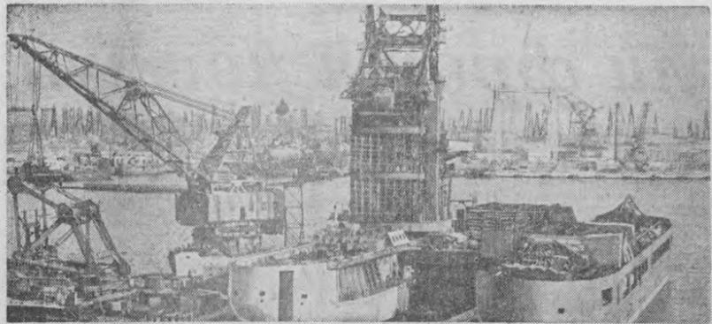
АЗЕРБАЙДЖАНСКАЯ ССР. Началось строительство двух корпусов строящегося в Баку универсального самолётного кранового судна-катамарана. Этот спортивный предельно быстрый для транспортировки и установки крупный морской основатель и нефтяных вышек на глубинах моря до 60 метров. Оба корпуса изготовлены на горьковском заводе «Красное Сормово». Демонстрация стальных корпусов велит прибывшая сюда бригада сормовских рабочих.
