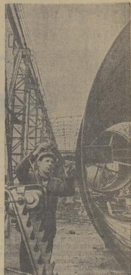
АЗЕРБАЙДЖАНСКАЯ ССР. Уникальный по своим габаритам джокер изготавливают на котельно-механическом заводе. Это 11-метровая стальная «птица» диаметром 2,5 метра. Первые две детали джокера, который будет сооружен на реке Талыш-чай близ Таузен, уже изготовлены. Работе и социалистическим предприятиям социалистическое обязательство — выполнить заказ гидростроителей республик досрочно, к 15 мая.
