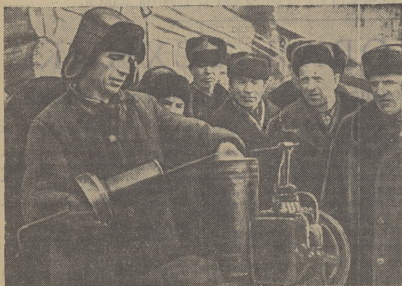
Мастер-наладчик К. С. Лазарев показывает участникам совета при-бор для проверки масляных фильтров тракторов. Фото В. Говорухина.
