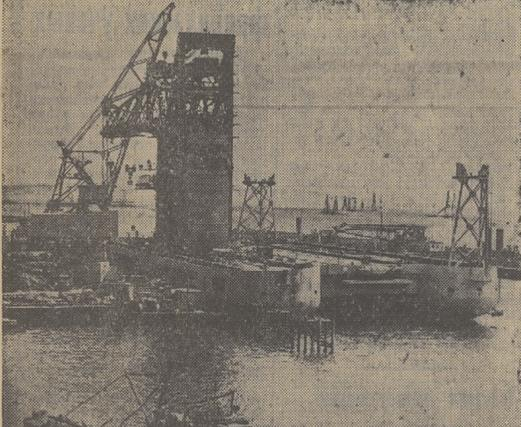
АЗЕРБАЙДЖАНСКАЯ ССР. В Баку развернулась деятельная подготовка к первому испытанию — выходу в море самоходного кранового судна — катамарана. Двухкорпусное крановое судно сооружено для нефтяников Каспия. Оно оборудовано транспортными и установочными мостками оснований на глубинах моря до 60 метров.
