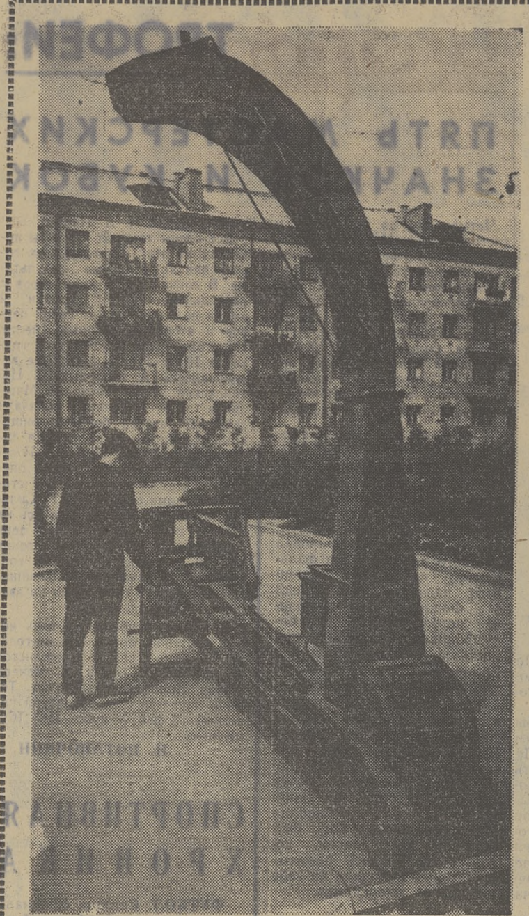
МОСКОВСКАЯ ОБЛАСТЬ. В отделе механизации Всесоюзного научно-исследовательского института кормов создана новая машина — погрузчик-аммонизатор «ПАС-ВИК», предназначенная для выгрузки силоса из траншей или буртов с одновременной обработкой его аммиачной водой. Эта машина может быть также использована для измельчения и погрузки в автомашины сена или соломы, собранных в стога и скирды. «ПАС-ВИК» работает с трактором типа «Беларусь» и обслуживает трактористом. Производительность его 10—15 тонн массы в час. Несколько таких машин уже работает в ряде колхозов и совхозов страны. На снимке: погрузчик-аммонизатор «ПАС-ВИК». (Фотокорреспондент ТАСС).
