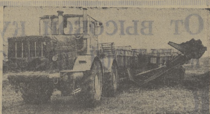
Курганский завод сельскохозяйственного машиностроения «Кургансельмаш» освоил выпуск новой продукции — тракторных самовывозных двухзубовых прицепов для вывоза органических удобрений на поля. Тракторный поезд, состоящий из трактора К-700 и двух таких прицепов, за один рейс вывозит на поле 24 тонны удобрений. В течение года завод планирует выпустить 300 таких прицепов. НА СНИМКЕ: загрузка прицепов органическими удобрениями. (Фотохроника ТАСС).
