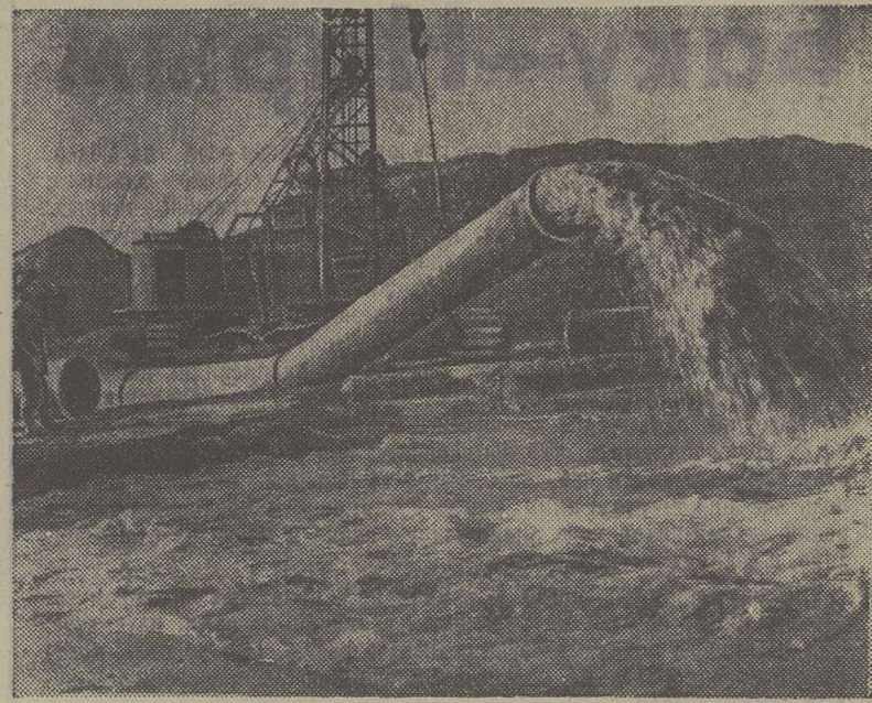
ТАТАРСКАЯ АССР. Нижнекамская ГЭС — одна из мощных станций энергетического каскада, сооружаемого в Волго-Камском бассейне. Сейчас на строительстве гидроузла заканчивается намынная продольная перемычка первой очереди котлована ГЭС. Мощные земснаряды уже намыли свыше 2 миллионов кубометров грунта. К открытию XXIII съезда КПСС строители обязались уложить первые кубометры бетона в основные сооружения гидростанции.
