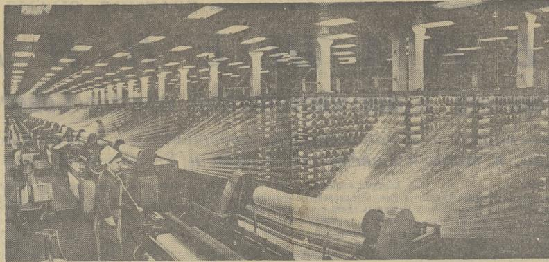
На Курском комбинате синтетических волокон вступил в строй действующих второй поток по производству кордной ткани. Теперь первая очередь ткацкого цеха напронового производства будет производить для шинной и резино-технической промышленности высокопрочного корда вдвое больше, чем в минувшем году.
