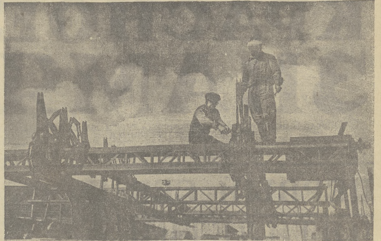
Год назад под руководством старшего конструктора Томского ЛПДК Вестислава Петровича Чугунова на комбинате начали изготавливать оригинальную сортировочную машину для сортировки круглого леса. Сейчас новая сортировочная машина прошла производственные испытания и показала хорошие результаты. Она производит пять операций на сортировке леса. А управляет ею один оператор. Новый агрегат, высвободив лесовладельцев, увеличит производительность труда и повысит качество сортировки.
