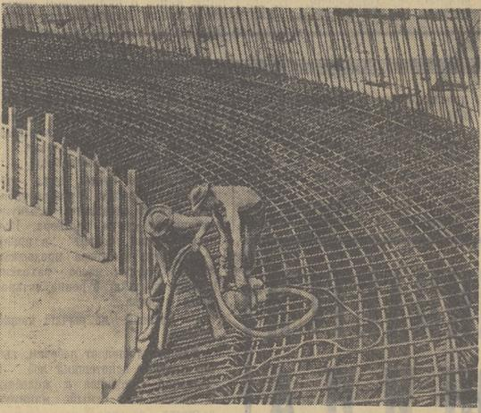
Рабочие уплотняют бетон, закладываемый в основание огромной дамбы.
