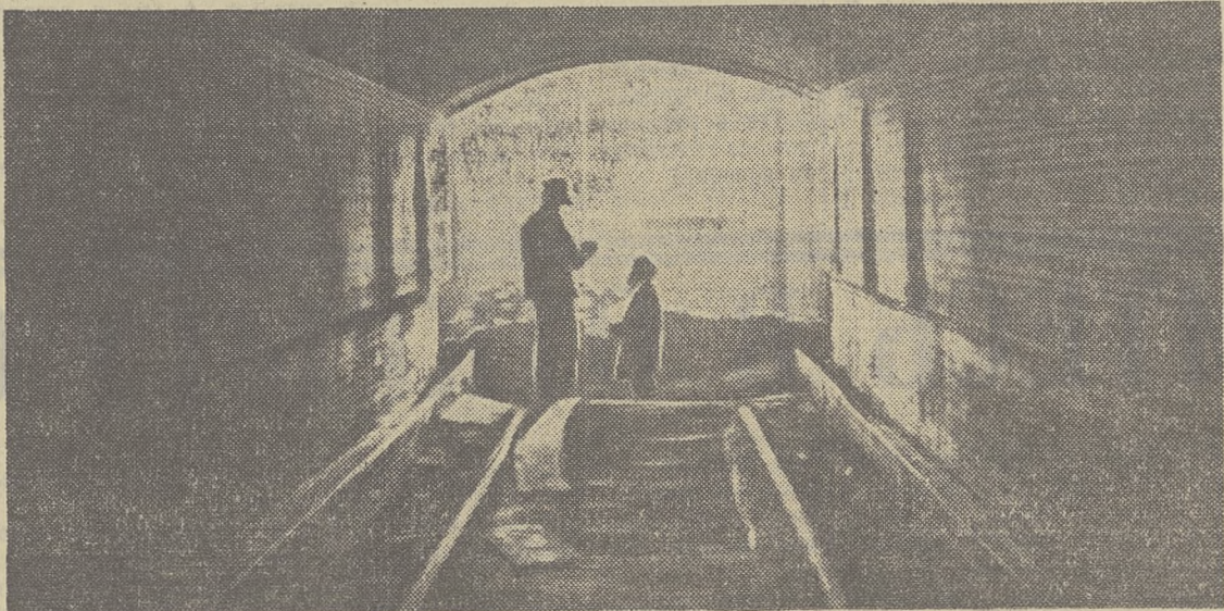
Почти на сто метров тянется туннель этой печи.
