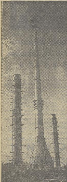
МОСКВА СЕГОДНЯ. На строительстве телевизионной башни в Останкине идет подготовка к установке антенны. Конструкция антенны, высота которой в собранном виде составит 140 метров, смонтирована на пяти специальных стеллах. Две из этих секций вы видите на снимке рядом с башней. Подъем конструкции антенны на 385-метровую башню будет осуществлен при помощи специальных мостовых кранов. Фото Н. Грановского. (Фотохроника ТАСС).
