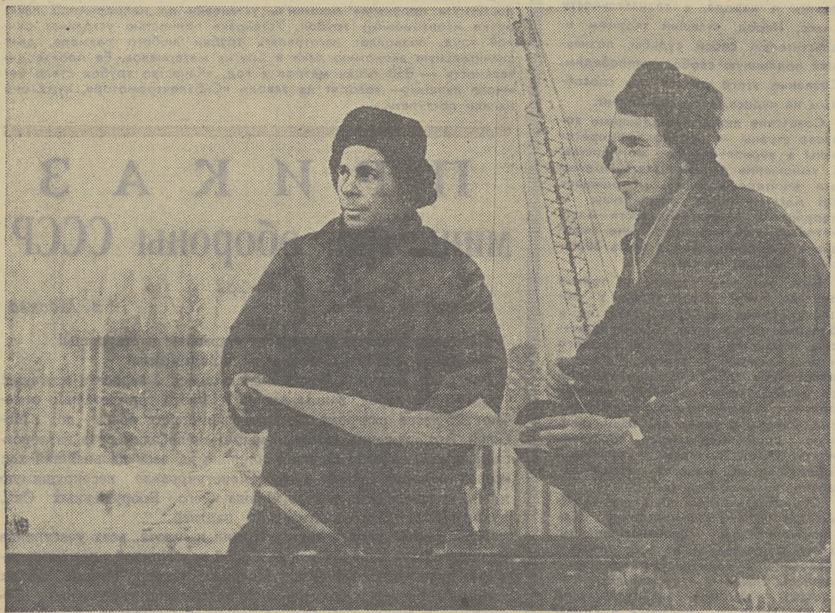
Недавно строители железной дороги Асино—Белый Яр выпрыгнули реку Чична-Юл в районе прохождения трассы. В этом месте через реку будет переброшен стометровый мост. Самоотверженно трудятся над возведением опор под будущий мост бригада Ивана Сатяева, одного из ветеранов мостостроения № 804. НА СНИМКЕ: бригадир Иван Сатяев (справа) и один из лучших монтажников комплексной бригады Константин Ураслов. Фото Ф. Хитриневича.
