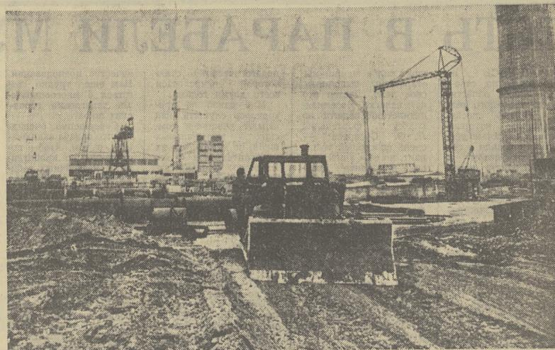
В северо-западной Чехии на базе залежей бурого угля создается мощный комплекс теплоэнергетики из семи электростанций на 5.300 тысяч киловатт. НА СНИМКЕ: на строительстве ТЭЦ «Почера-ды».
