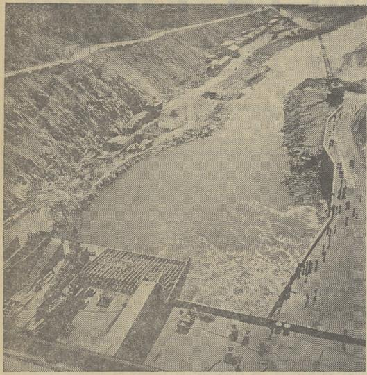
В Наглу при техническом содействии Советского Союза сооружается крупнейшая в Афганистане гидроэлектростанция мощностью 90 тысяч киловатт. Сейчас идет монтаж третьей турбины. Первый и второй агрегаты уже подключены к энергетической сети и дают ток Кабулу и Кульбахарскому текстильному комбинату. К лету 1967 года будет полностью завершено строительство ГЭС.
