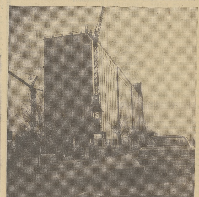
В столице Афганистана Кабуле с помощью советских строителей недавно закончено сооружение второй очереди элеватора. Сейчас начались работы по расширению мельницы и хлебозавода.
