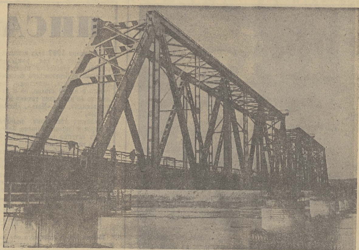
Стальная магистраль Подобассе—Артышта протяженностью 130 километров сооружается неподалеку от Новокузнецка (Кемеровская область).
