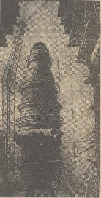
37-метровая красавица-домна сантиметр за сантиметром движется на стальных катках к своему постоянному «местожительству». До него 2.100-тонной печи — 20 метров.
