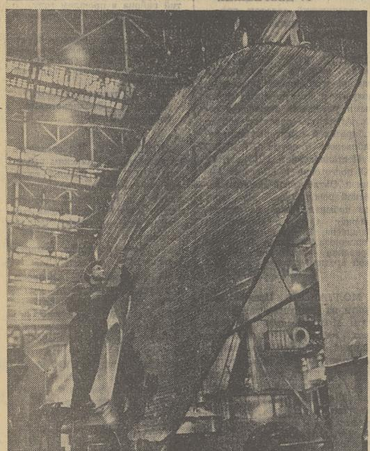
**ЛЕНИНГРАД.** В первые дни нового года на Металлическом заводе имени XXII съезда КПСС начато изготовление очередной турбины для крупнейшей волжской новостройки — Саратовской ГЭС. Эта гидроэлектростанция будет оснащена уникальными поворотными лопастными турбинами. По своим размерам они превосходят даже краснопольские агрегаты. Диаметр рабочего колеса саратовской турбины превышает десять метров.
