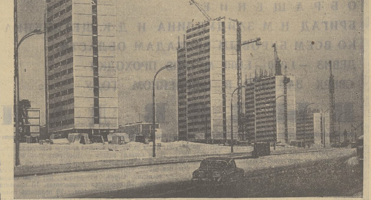
МОСКВА. В начале Ленинского проспекта сейчас идет большое строительство каркасно-панельных 19-этажных жилых домов, каждый дом будет иметь 190 квартир. В первых
