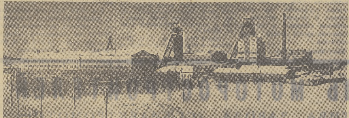
Слана в эксплуатацию новая крупная шахта комбината «Ростовуголь» — «Гуковская» № 8. Она будет давать 1,5 миллиона тонн угля в год. Эксплуатационники новой шахты дали слово освоить в течение года проективную мощность предприятия. НА СНИМКЕ: общий вид надземных сооружений шахты «Гуковская» № 8. Фото В. Турбина. (Фотохроника ТАСС.)
