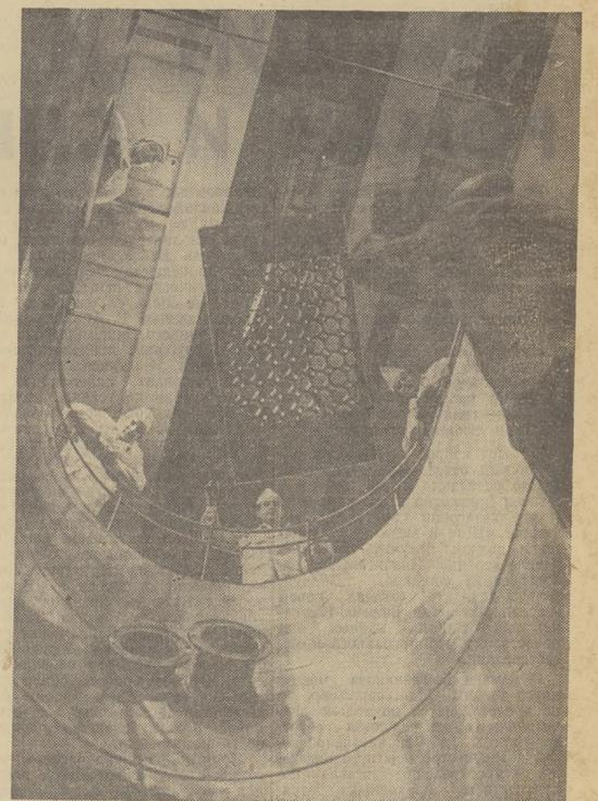
Близится день пуска исследовательского реактора научно-исследовательского института ядерной физики при ТГУ. Сейчас на реакторе проводятся гидравлические испытания, устроятся медные непопадки. НА СНИМКЕ: идет монтаж решетки активной зоны реактора. Фото П. Иванова.
