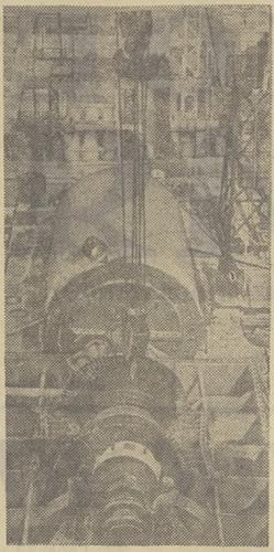
Почти двух миллионов киловатт достигнет по окончании строительства мощность Ташкентской ГРЭС, работающей на природном газе. Принимает промышленную нагрузку пятый турбогенератор.
