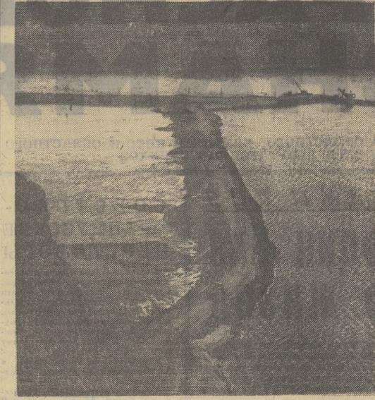
В Усть-Ильме, где сооружается третья гидроэлектростанция Ангарского каскада, — временное затишье. Успокоилась Ангара, прорвавшая в апреле верхнюю перемычку строящегося котлована. Позади волнения и бессонные ночи строителей, задержавших гитание бреша в перемычке. А впереди новые дела: наращивание верхней и продольной перемычек, насыпка нижней перемычки. К сентябрю эти работы будут закончены, после чего на котловане откачают воду.
