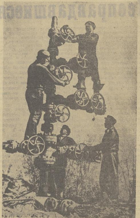
Буровая вышка перекочевала на другое место. А здесь остается фонтанная арматура. Ее-то и осматривают в последний раз бурильщики вахты В. Н. Макарова. НА СНИМКЕ: Н. Аболещев, В. Поляков, М. Капанов, В. Макаров.
