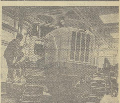
Тусеничный трактор Т-130 успешно выдержал государственные испытания. Работники Челябинского тракторного завода готовятся к серийному выпуску этой машины, значительно превосходящей по мощности тракторы Т-100 различных модификаций.
