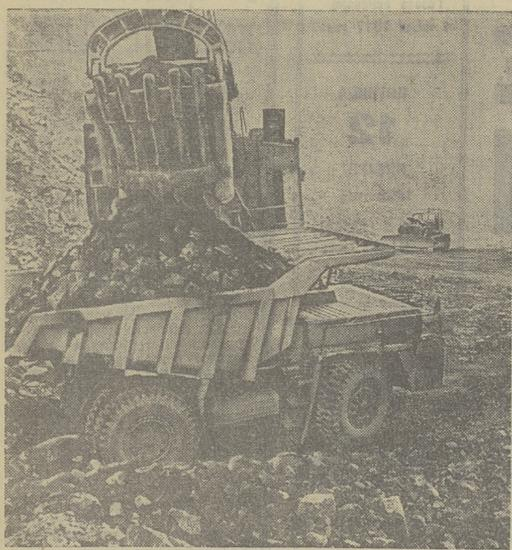
ТАДЖИКСКАЯ ССР. Строители Нурекской ГЭС возводят уникальную насащенную плотину, которая поднимется на высоту в 300 метров. Уложат в нее 58 миллионов кубометров ма-
