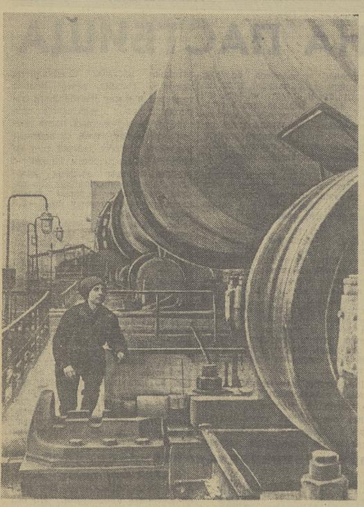
ВОЛЬСК (Саратовская область). На крупнейшем заводе «Большевик» пущена новая, одиннадцатая по счету технологическая линия производства цемента. Вращающаяся печь этой линии — 185 метров длины. Она способна выдать 72 тонны клинкера в час.
