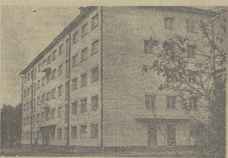
На днях в новый дом на ул. Енисейской въехали первые новоселы — рабочие манометрового завода. Это первое благоустроенное общежитие завода на 300 мест. Строители постарались сдать дом с отличным качеством. Над строительством общежития шефствовала комсомольская организация завода. Почти готов и еще один полароб. рабочий завод: 160 мальчишек и девчонок на днях откроют пионерский сезон в новом лагере в районе с. Калтан.
