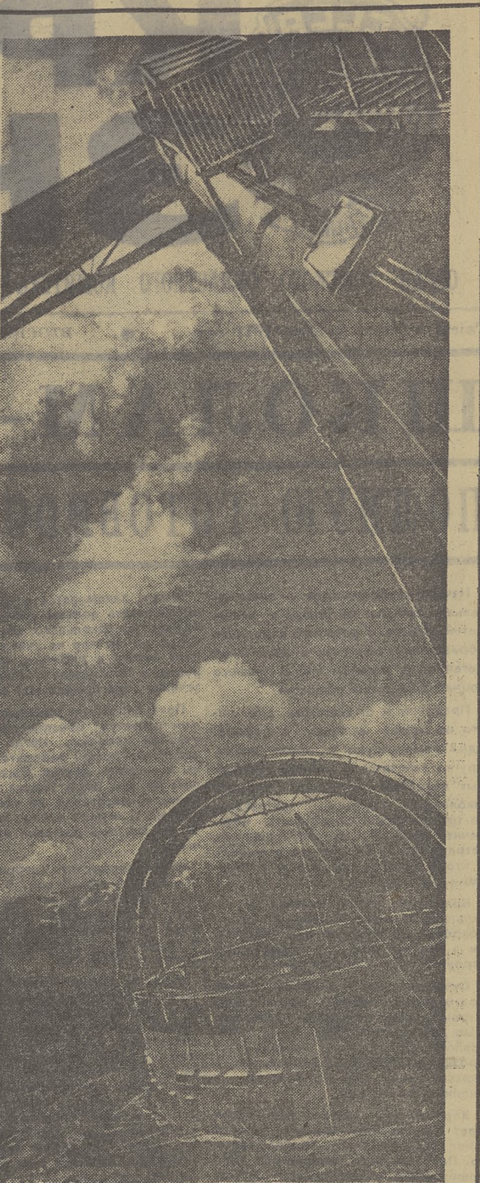
СТАВРОПОЛЬСКИЙ КРАЙ. На строительство астрофизической обсерватории Академии наук СССР прибыли первые элементы самого крупного в мире телескопа. Диаметр его зеркала равен шести метрам (диаметр зеркала крупнейшего сейчас телескопа Маунт-Паломарской обсерватории в США равен пяти метрам). Этот гигант построен Ленинградским оптико-механическим объединением.
