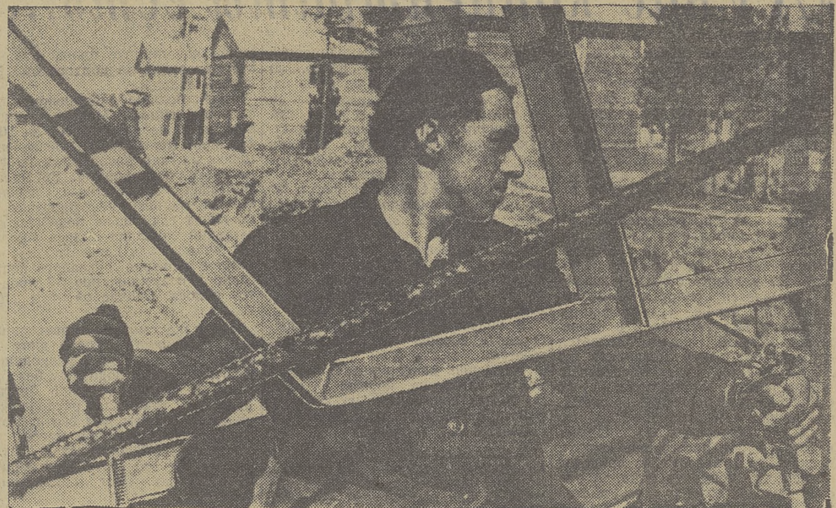
Совсем недавно приехал в Стрежевой Анатолий Волков и уже успел зарекомендовать себя хорошим работником. Его трубоукладчик можно увидеть на различных участках будущей нефтяной столицы Томской земли. Растут дома и растут километры труб для водопровода, подачи тепла, канализации — километры, уложенные Анатолием Волковым. Фото В. Чупаченко.
